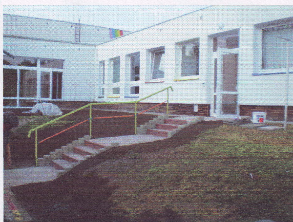
Pohled na nový vstup a fasádu
