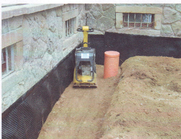
Odizolování suterénního zdiva
