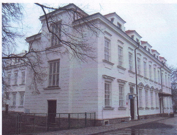
Celkový pohled – po opravě fasády
