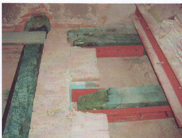
Oprava stropů v půdním prostoru
