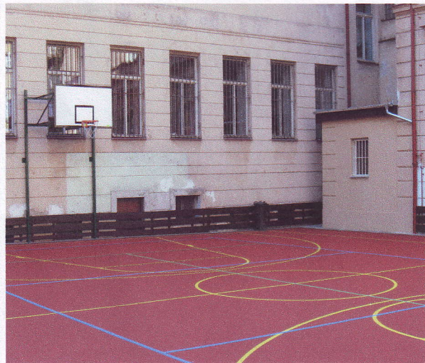
Nové hřiště, dostavba šaten
