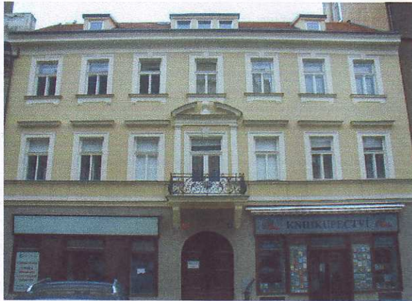
Čelní pohled na rekonstruovaný objekt
