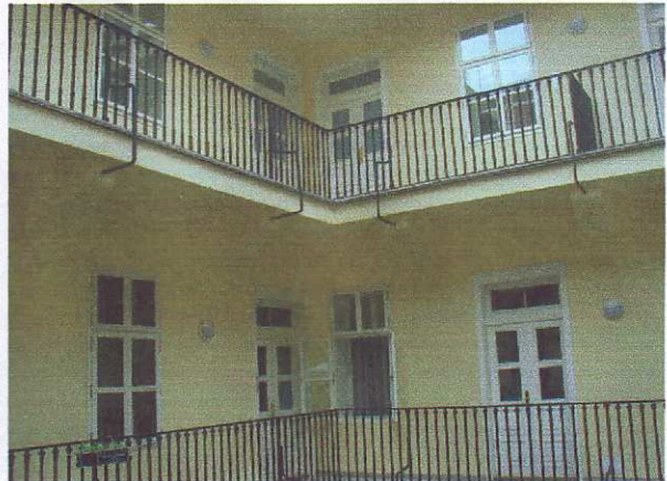
Rekonstruovaná fasáda a zábradlí na pavlačích
