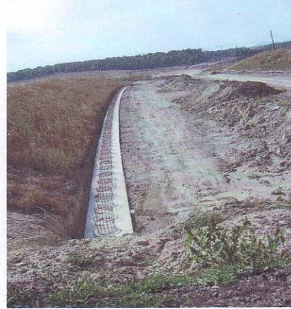
Pohled – pilotové základy
