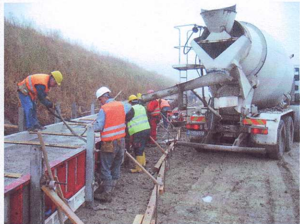
Provádění betonáže žlb. trámu
