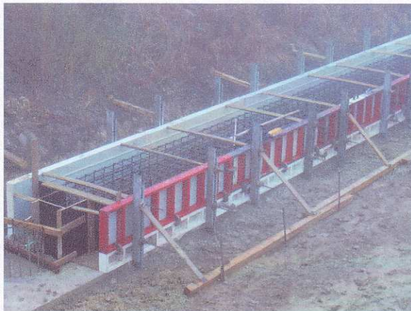
Sytémové bednění – žlb. trám
