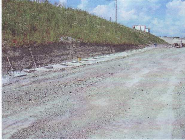
Vodící zidky pro piloty
