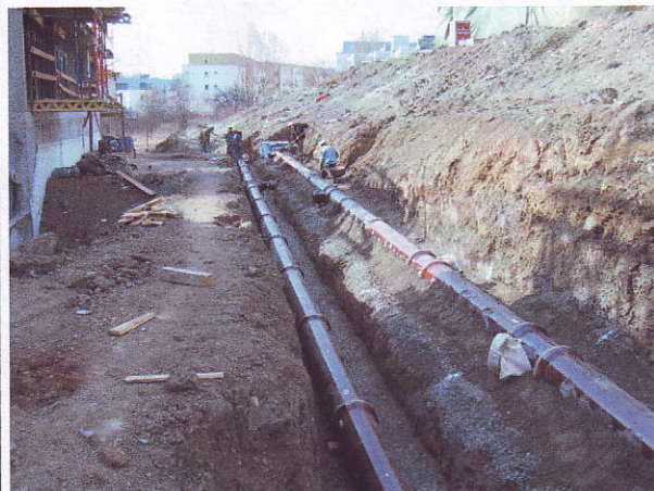
Pokládka kanalizace – splašková a dešťová
