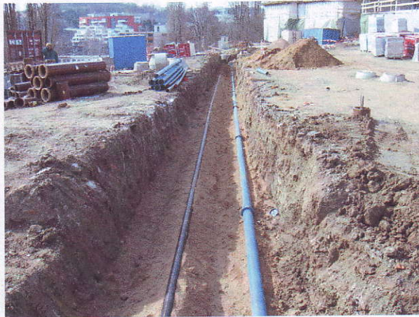
Pokládka potrubí – voda a plyn
