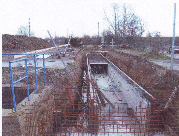
Pohled na žlab – betony, bednění, výztuž
