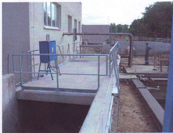
Žlab – strop, zábradlí, v pozadí vírový separátor
