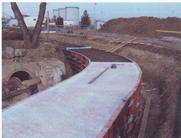
Betonáž kanálu – žlab oddělení dešťových vod
